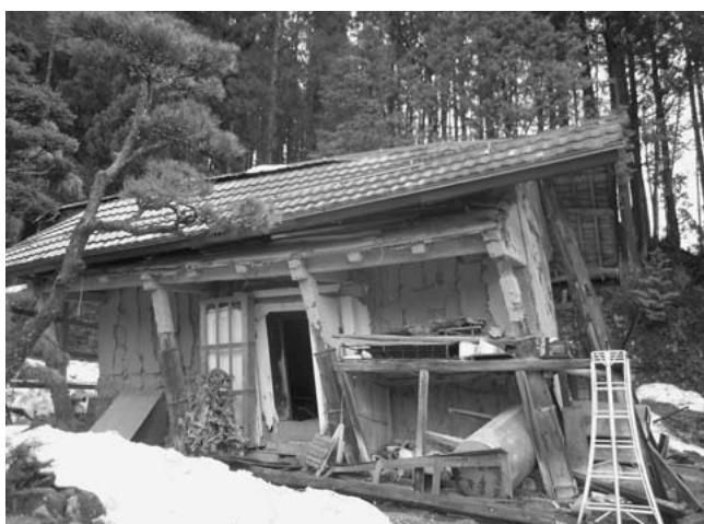
図1 白馬村堀之内地区 建物被害の様子
