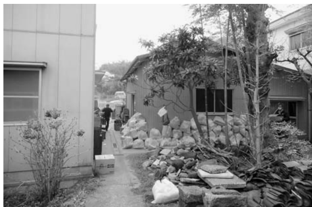
図2 作業日の敷地内
