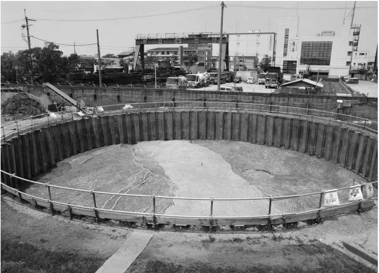
1. 第3面 全景 (南から)
