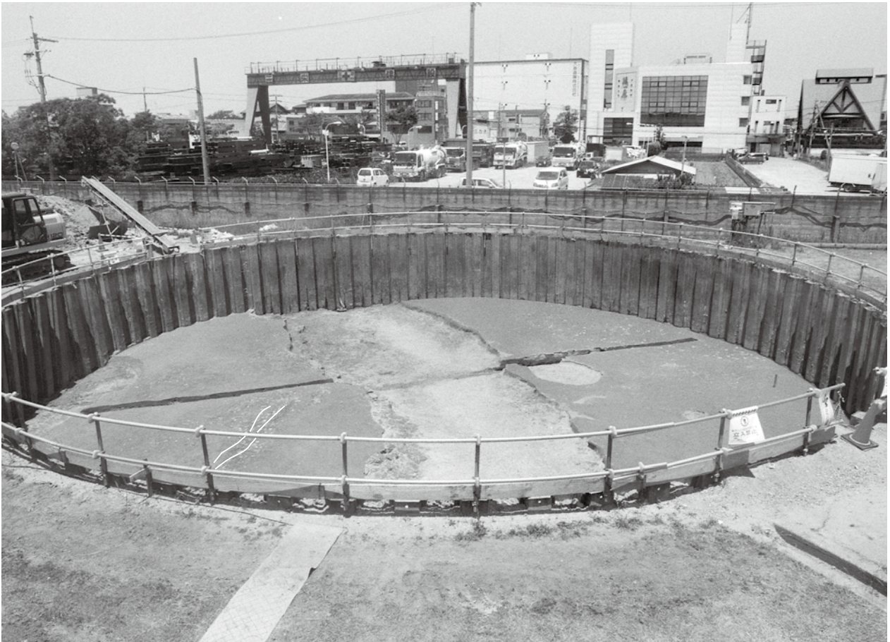
1. 第4面 全景 (南から)
