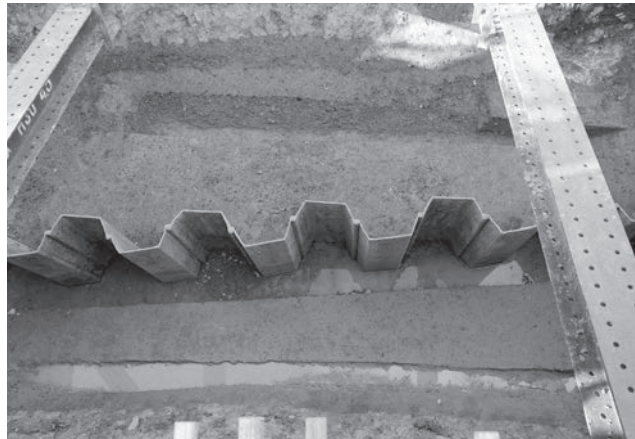
5 3区第2層除去面と北壁断面（南から）
