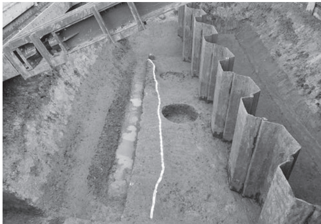
4 3区第2層除去面（西から）
