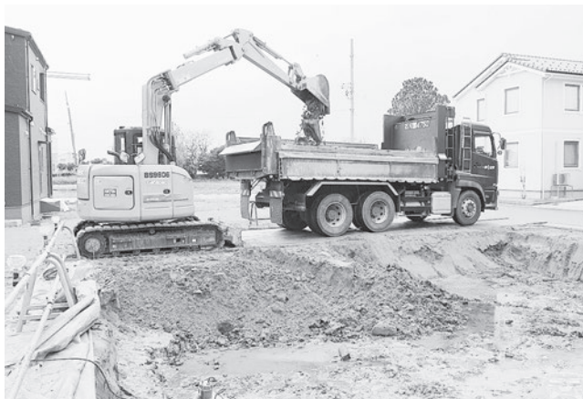
造成土の鋤取りと搬出状況
