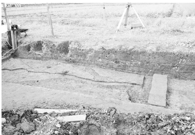
調査区北側断面（南から）
