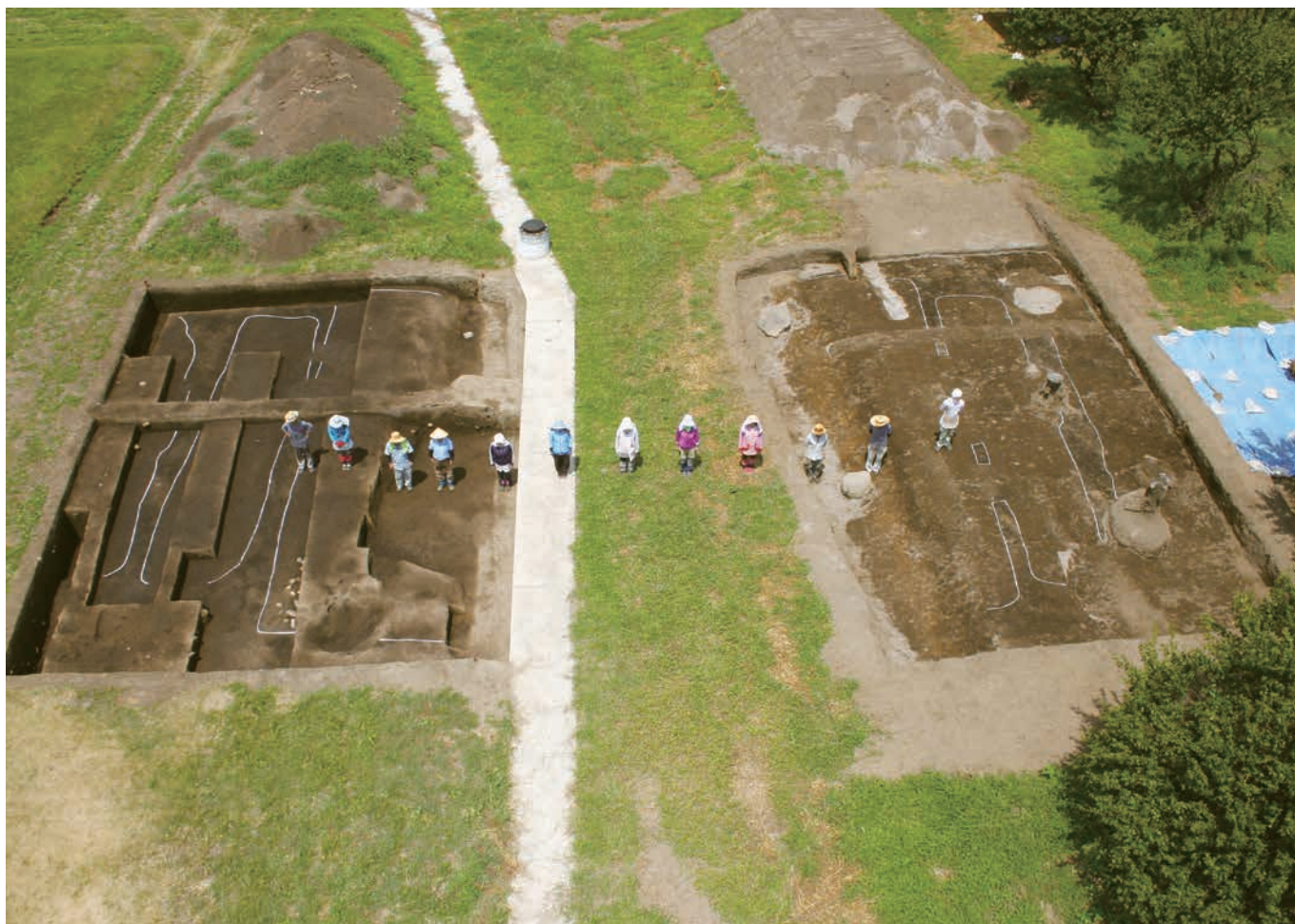
2. 中門全景(南上空から)
