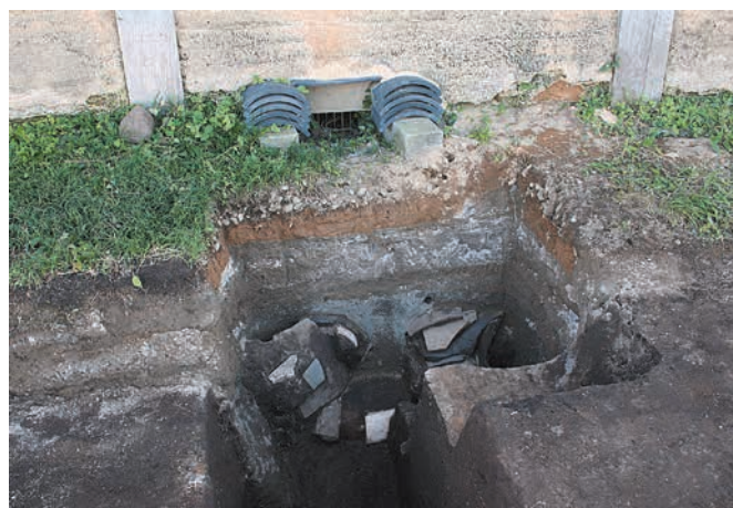
4. 42-9トレンチ暗渠と復元暗渠(北から)
