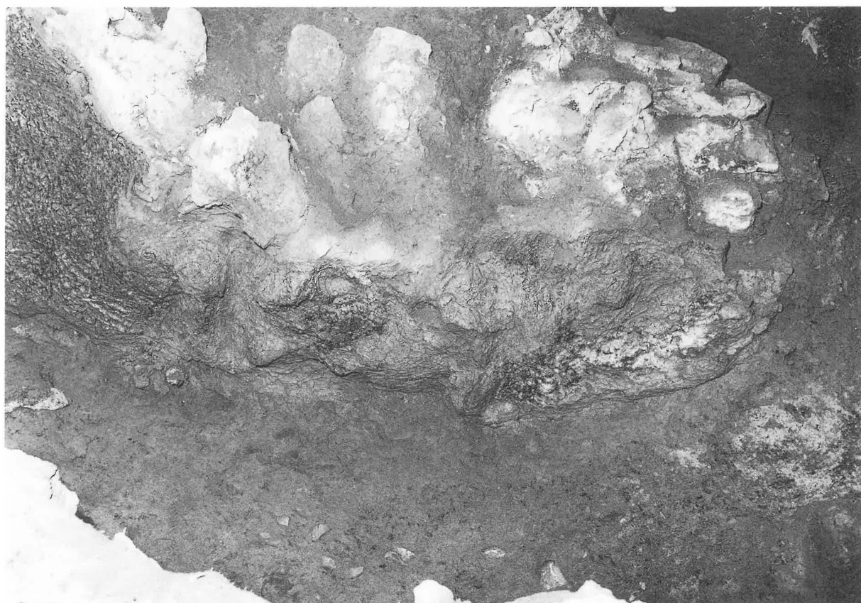
2 5号窯燃成室右壁-2
