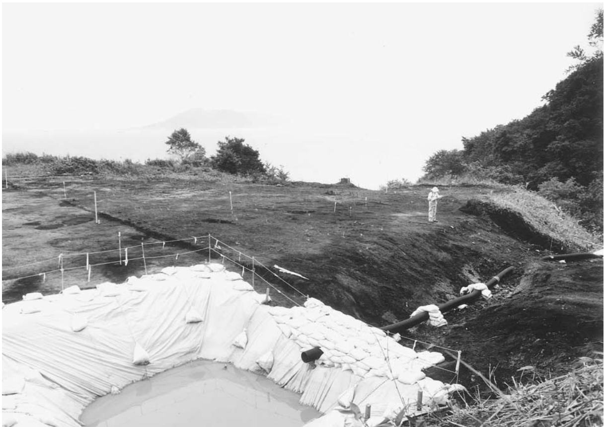
B地区 調査前状況（北西から）
