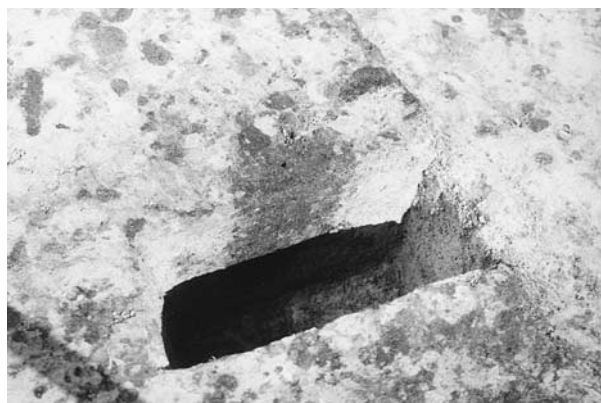
H-3 HP-3 セクション (南西から)
