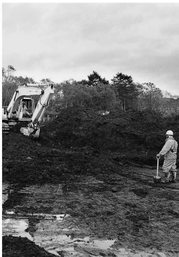
2 X層調査状況（北西から）
