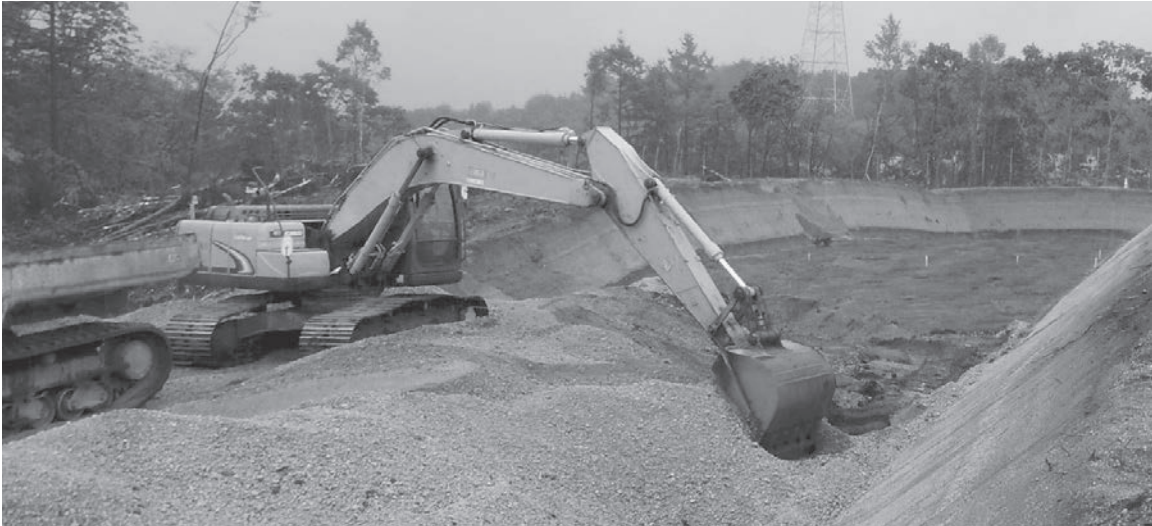
1. 表土・Ta-b層 除去作業（北西から）
