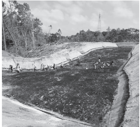
3. 調査状況（北西から）
