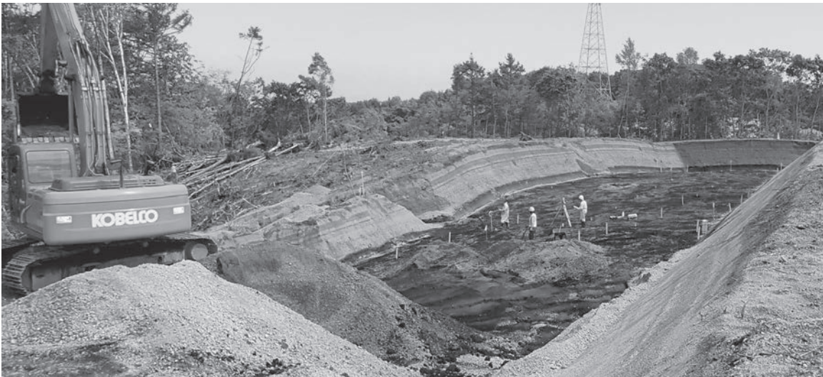
2. 表土・Ta-b層 除去作業および測量業務（北西から）
