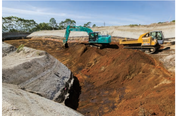
2. Ta-d 層 除去作業 (北から)
