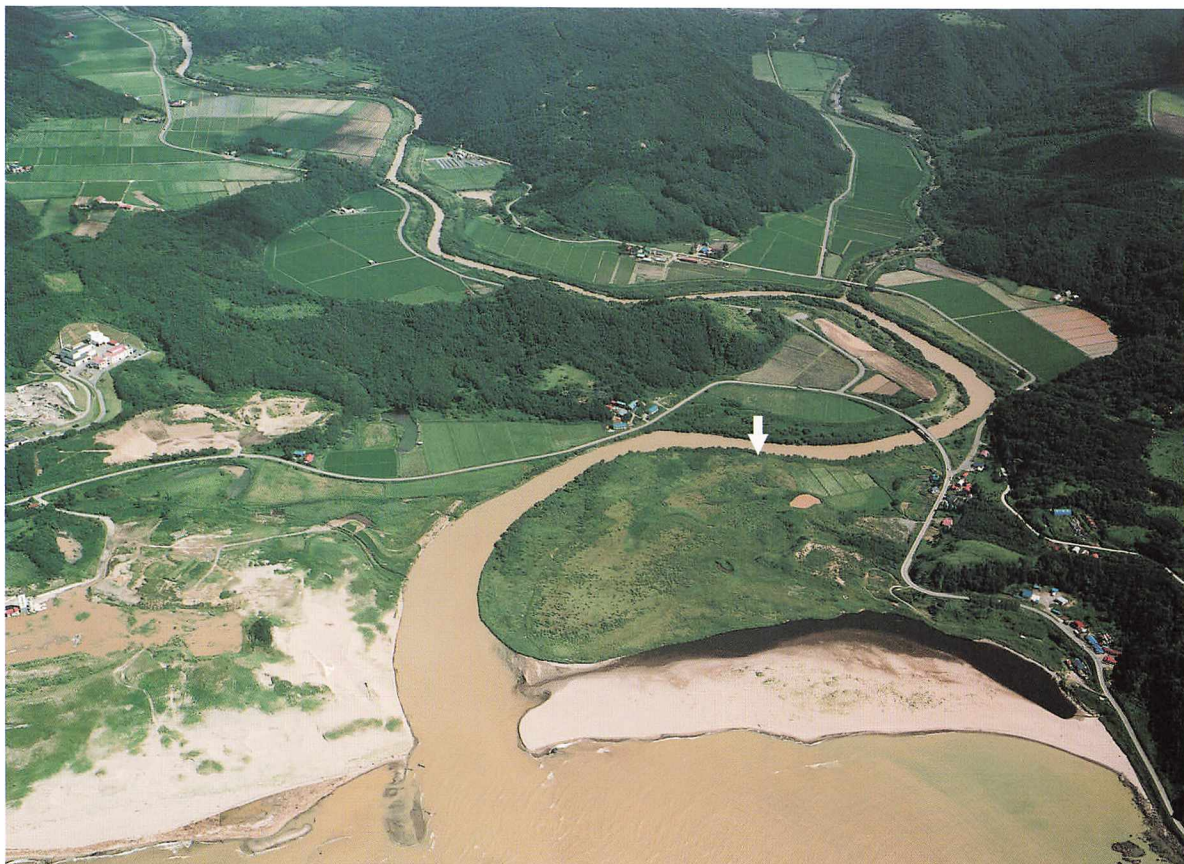
1 遺跡空中写真 (北海道函館土木現業所提供)
