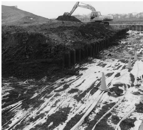
保護用シート設置状況
