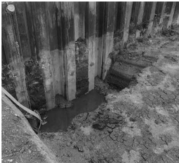
カマ場設置状況
