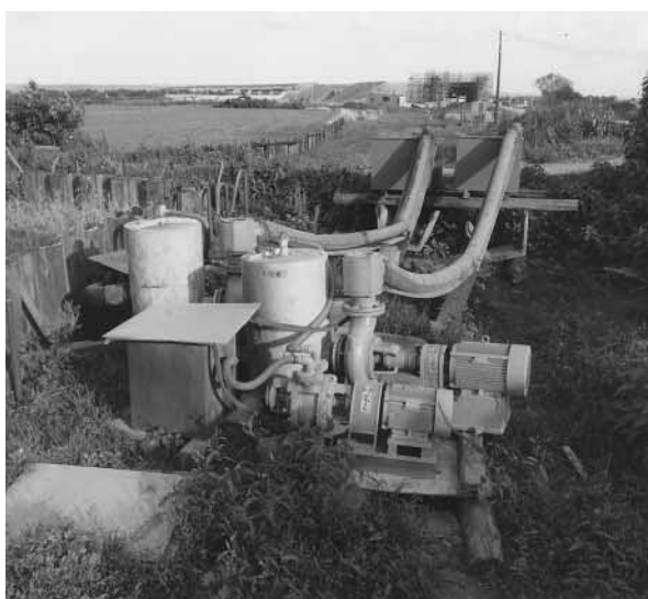
ウエル・ポイントメインポンプ
