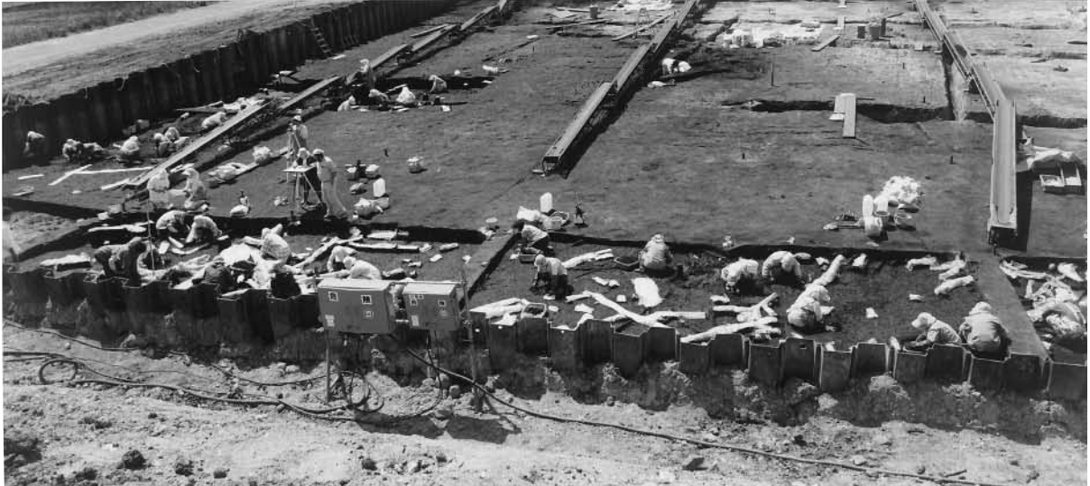
調査風景 NE SW
