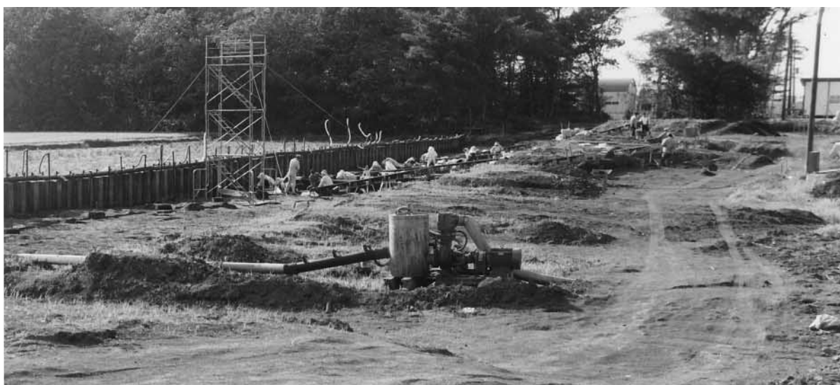
ウエル・ポイント設置状況
