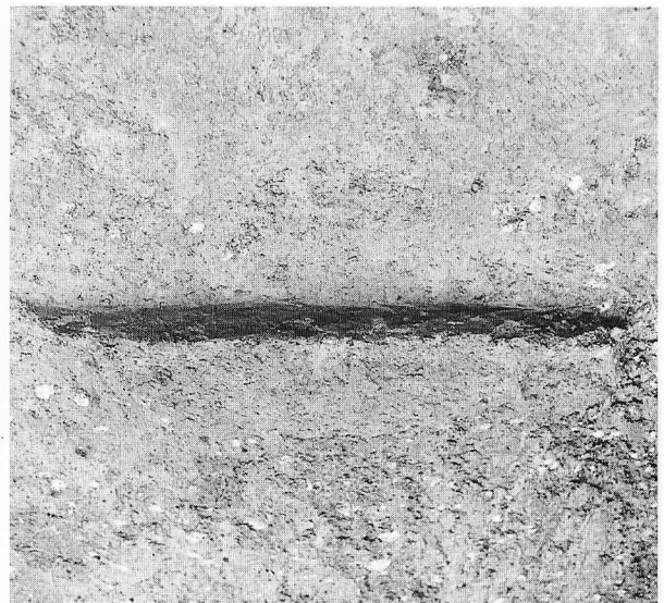
4 C-1セクション (北東から)
