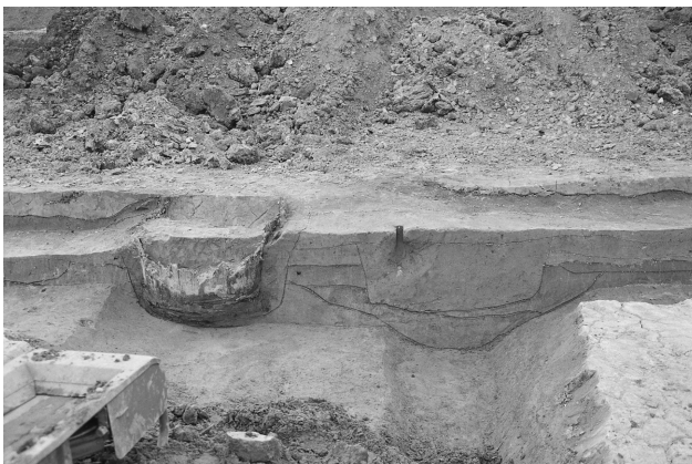
53、1トレンチ南東壁 (187 段差付近) (北西から)
