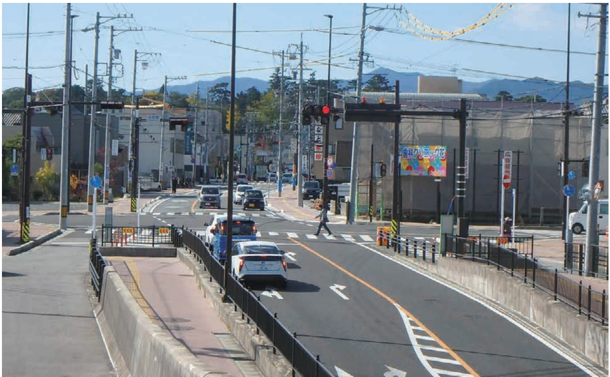
調査後（現状）風景一本町東交差点から松坂城方面（南方）を望むー（北東から）
