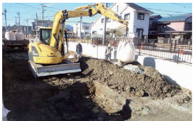
12区路床改良時立会状況（西から）
