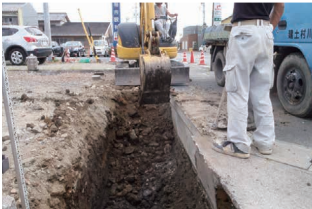
2区東側調査状況 (南西から)
