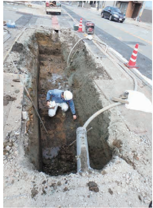
2区調査風景（南東から）
