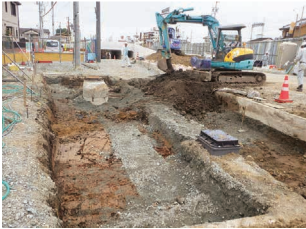
9区調査状況（南から）
