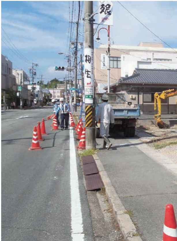
調査前風景 (北東から)
