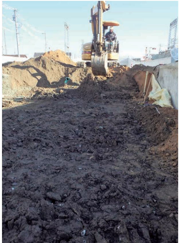
12区SZ550検出状況（南西から）
