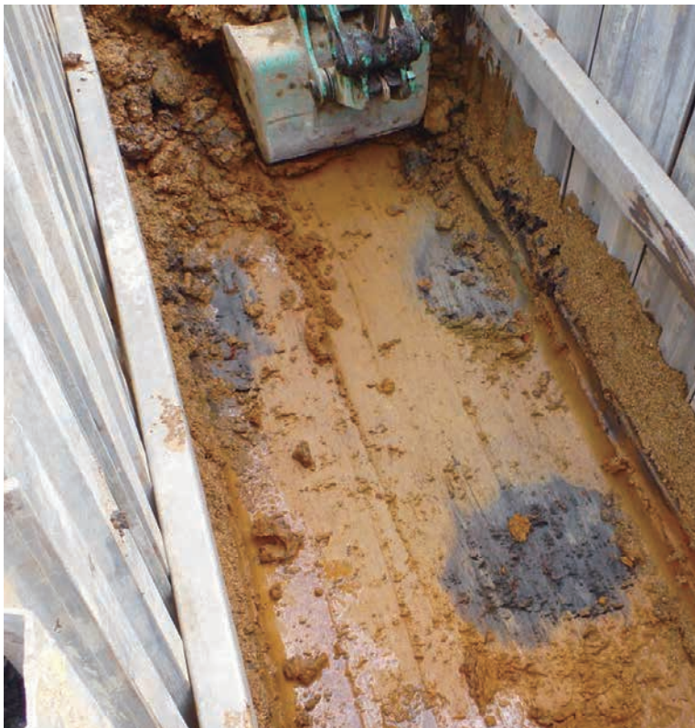
7区調査状況（南西から）
