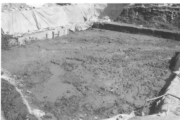
V面 全景(南西から)
