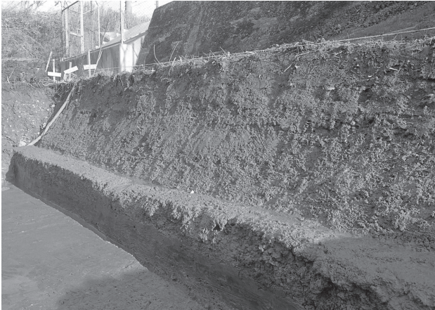
3. 2区 南壁断面 (北西から)
