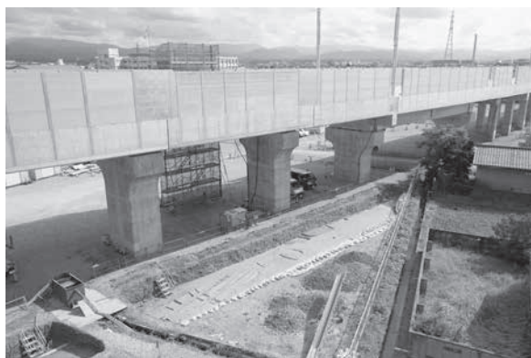
I区完掘状況 (北西から)
