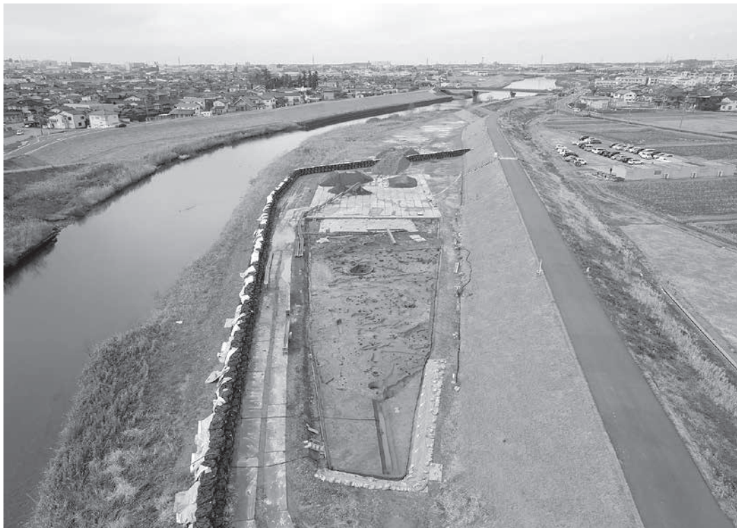
調査区遠景 (東から)
