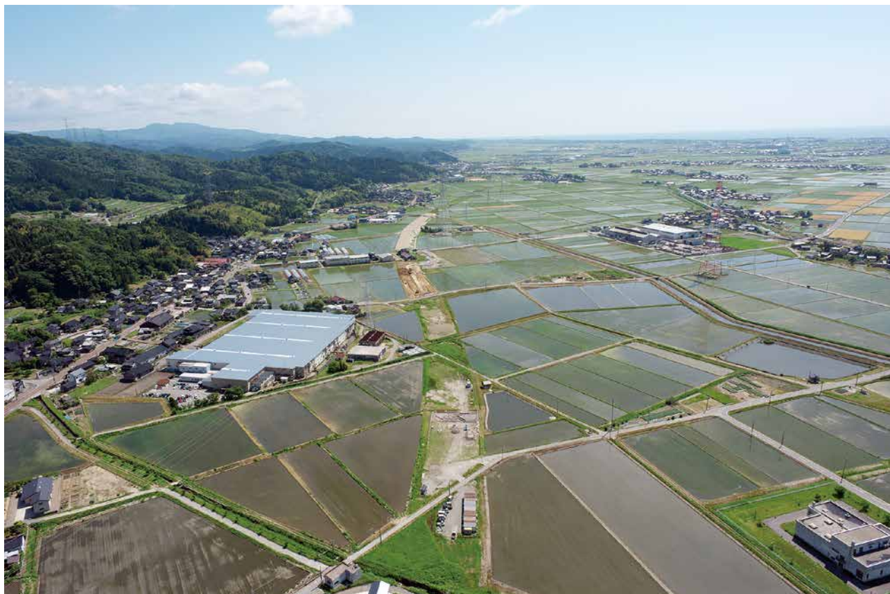
調査区遠景（北東から）
