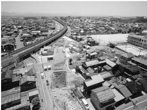
写真1 園町遺跡上空から見た小松駅方向（北から）
