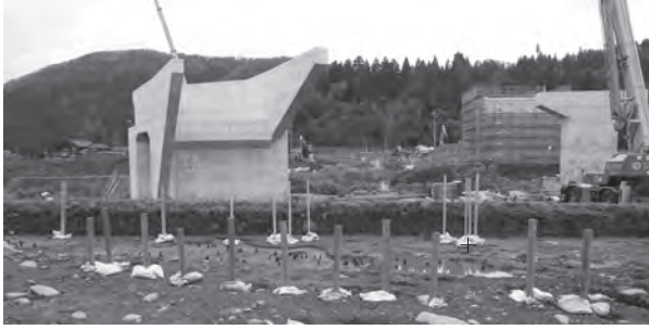
復元した板塀・柵列（現地説明会）
