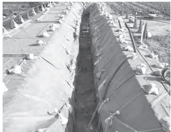
調査区東半完掘状況
