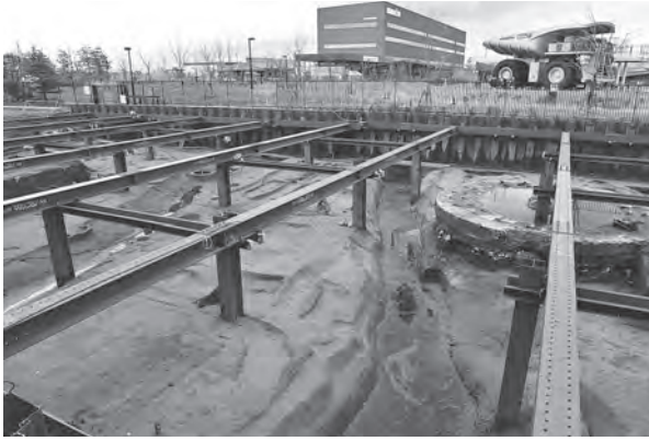
環濠 1・2 完掘状況 (西から)
