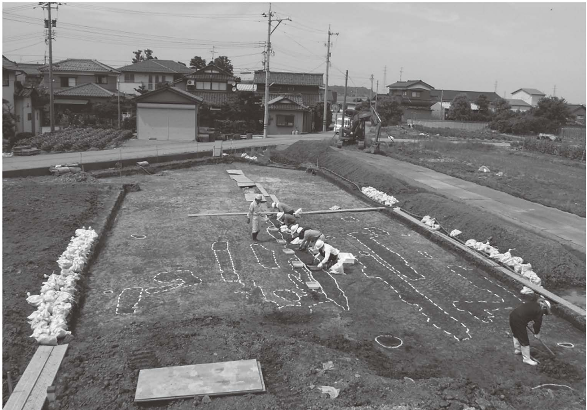
作業状況（調査地北部）
