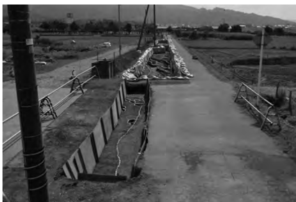
Q区 遺構掘削後状況（北から）
