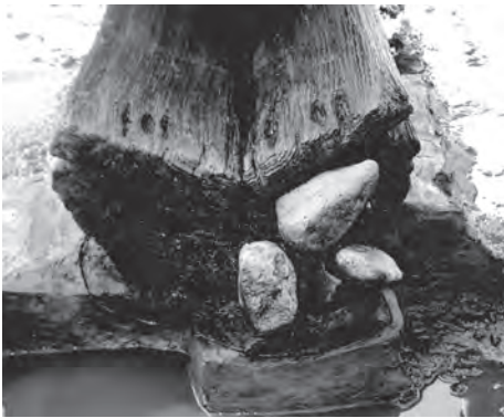
Ⅲ区木樋北側木口
