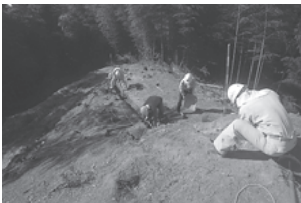
作業風景（斜面部トレンチ掘削）
