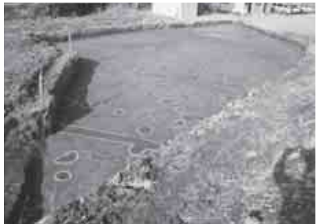
遺構検出状況 (南から)
