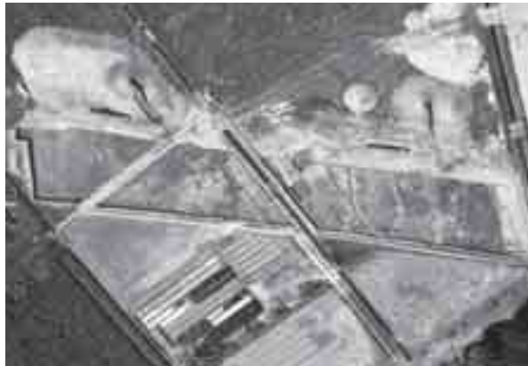
B区下層 俯瞰
