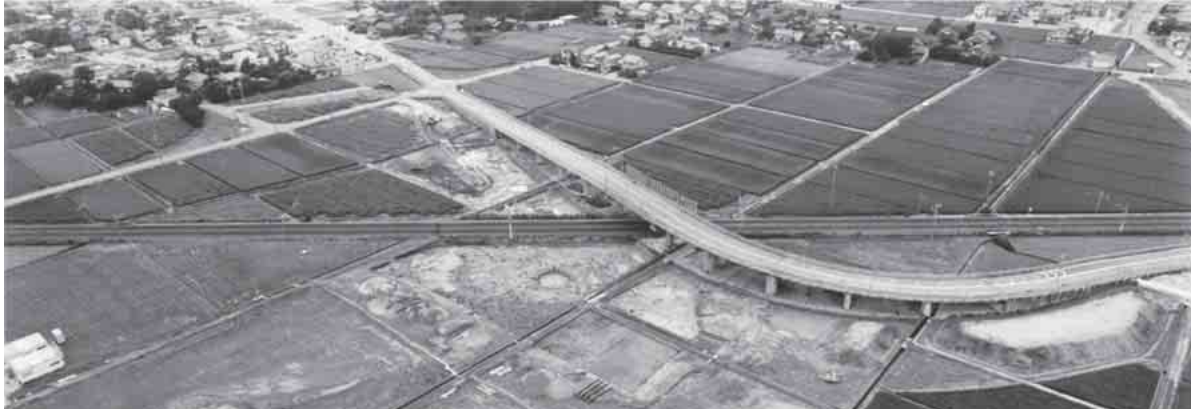
調査地遠景（南東から）
