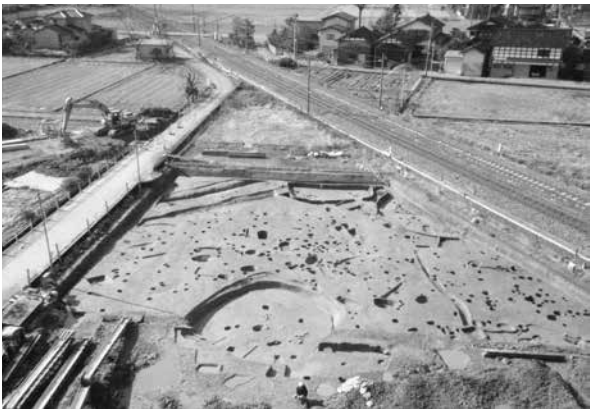
B区 西側 完掘状況
