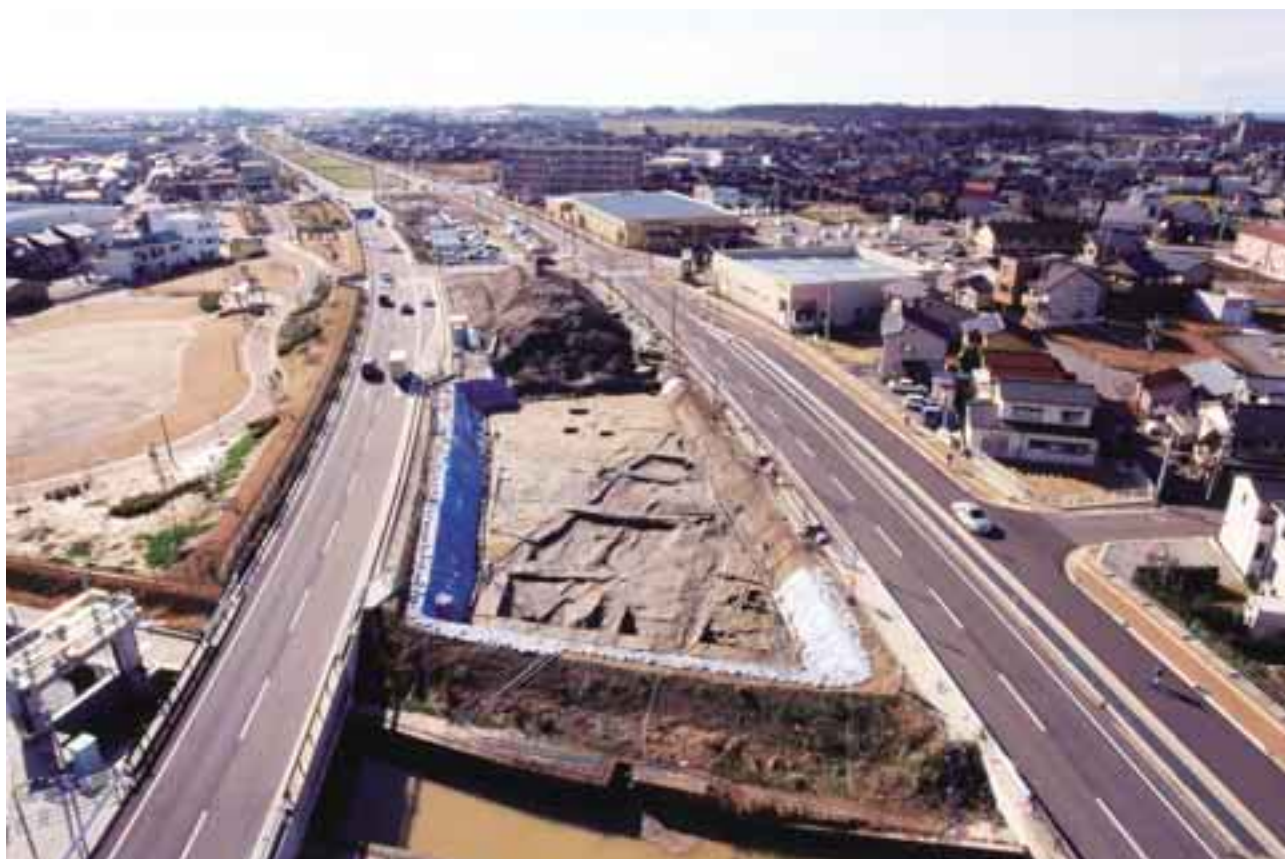
調査区遠景（2b区：東北から）
