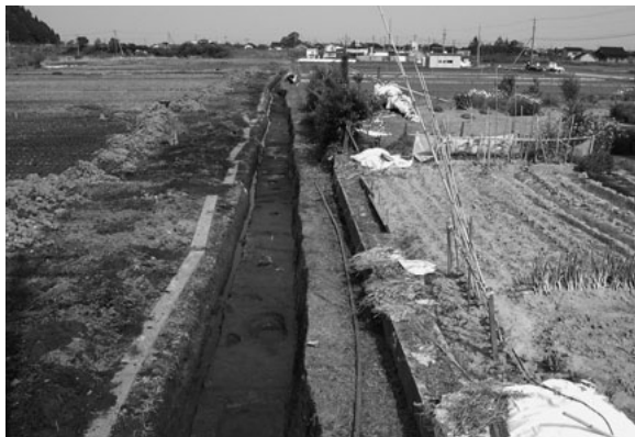
B区②完掘状況（西から）
