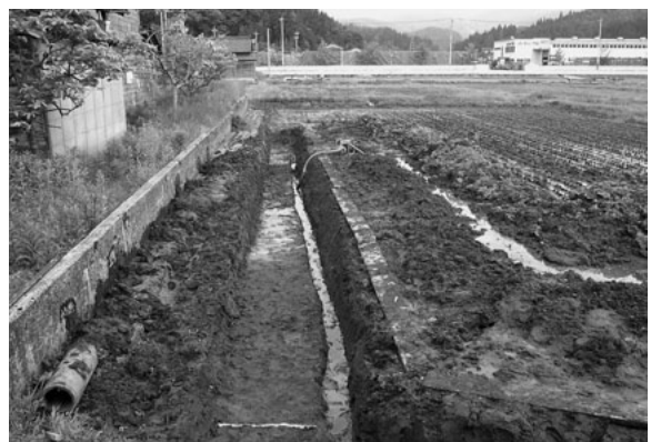
C区③完掘状況（東から）
