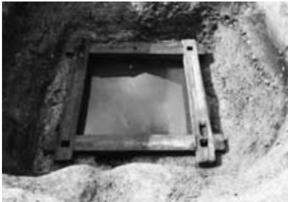
写真7 B地区 SE02井戸枠基礎
