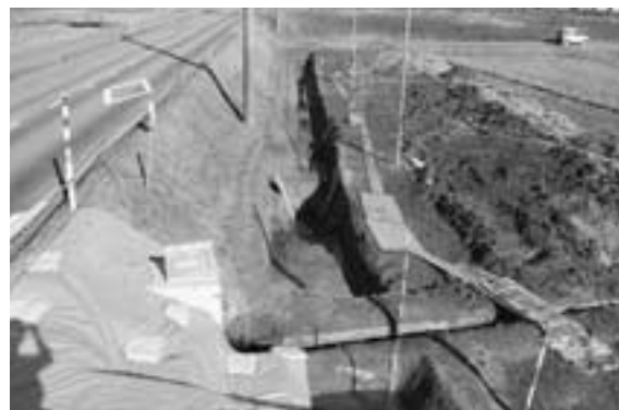
下層完掘状況 (南西から)
