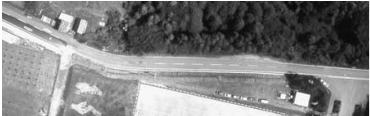
調査区全景 (上空より)
