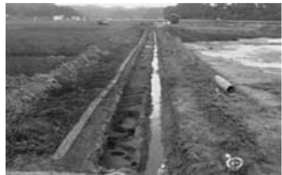
トレンチ 東側完掘状況
