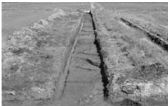
トレンチ 北側完掘状況
