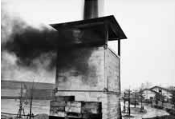
写真10 排煙孔よりの黒煙、炎
