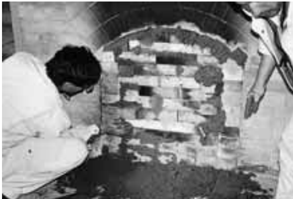
写真12 焚き口閉塞作業風景 2
