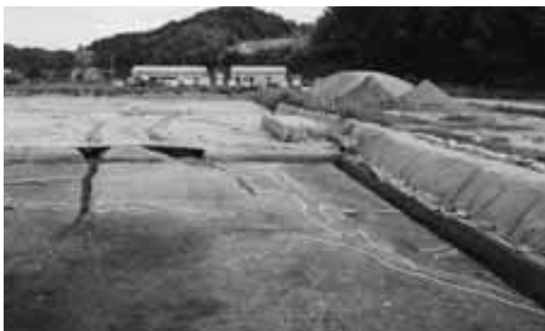
B区水田跡（西から）
