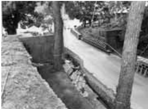
河北一ノ門と石組側溝（北東から）
