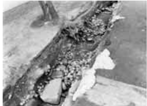
河北二ノ門 石垣台根石（南東から）
