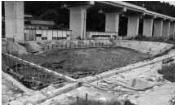
完掘状況（東から）
