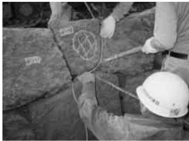
写真1 石垣の解体風景
