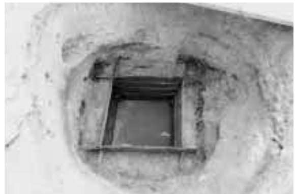
G地区 面SE4001(側板3段目まではずした状態))
