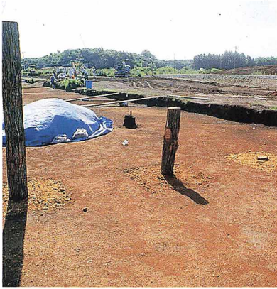
杭高割出し実験
