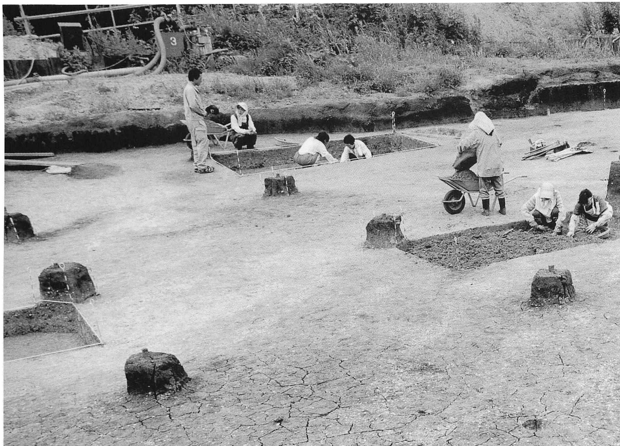
1 VI・VII層の調査状況（南西から）
