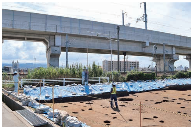
空中写真測量作業(北から)
