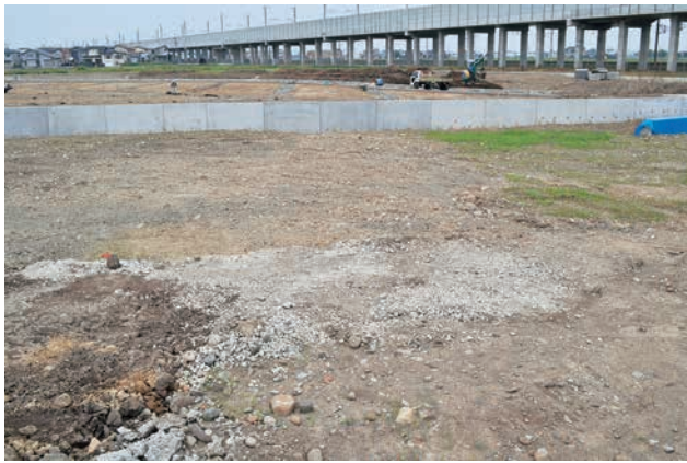
着手前(東から)
