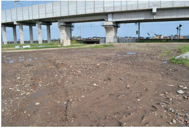
着手前(南東から)
