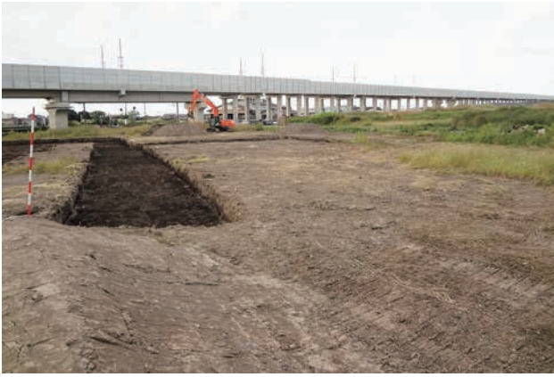
着手前(南西から)
