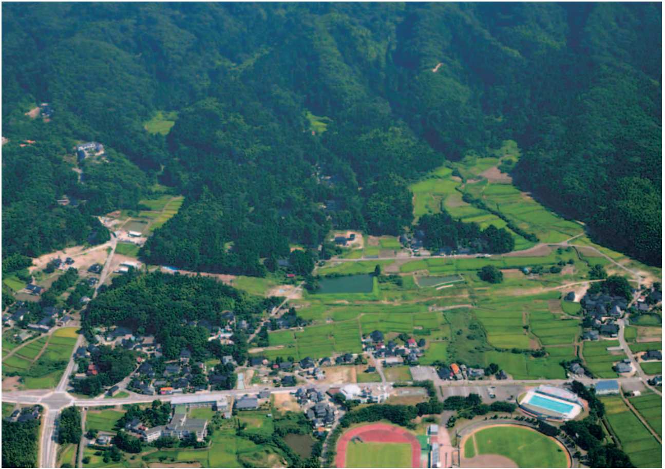
七尾城跡と能越自動車道路線（北西から）
