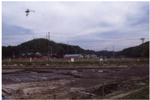
第2回航測作業風景(西から)
