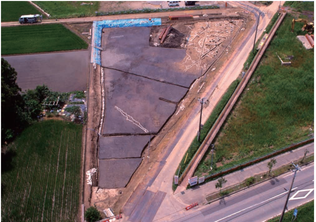
完掘状況(西から)
