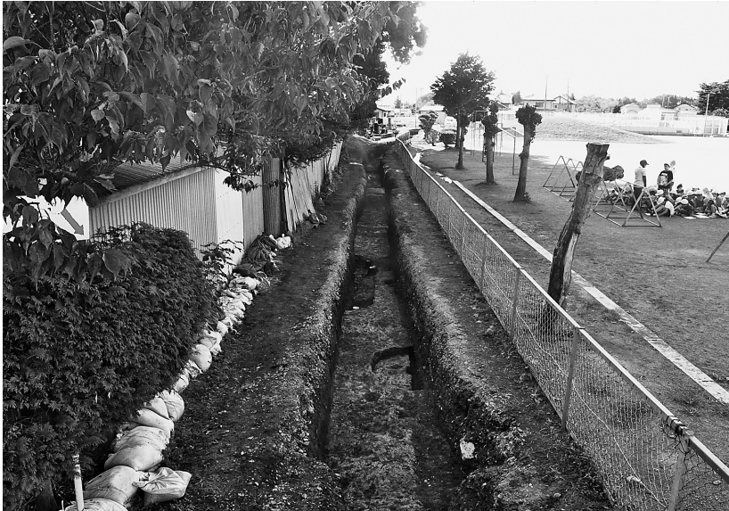
第 31 次調査区 全景 (東側から)
