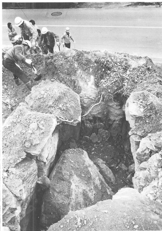
3 調査前の玄室部(北西から)
