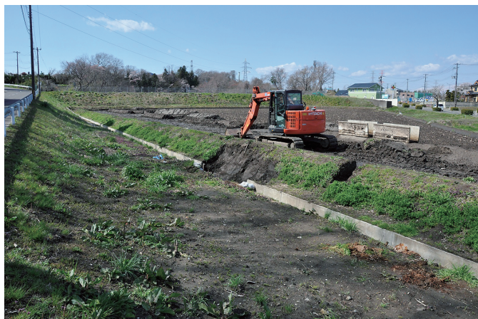
① 調査前状況（北東から）
