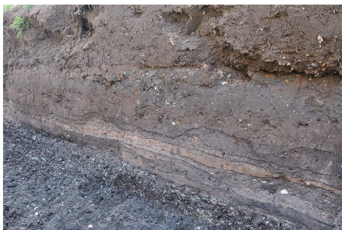
⑤ 遺物包含層 西壁断面状況（北東から）
