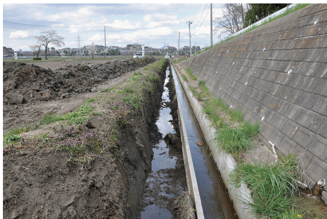
② 掘削後状況（南から）
