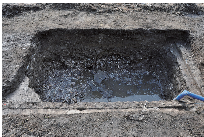
⑦ 3トレンチ 南西壁断面状況（北東から）
