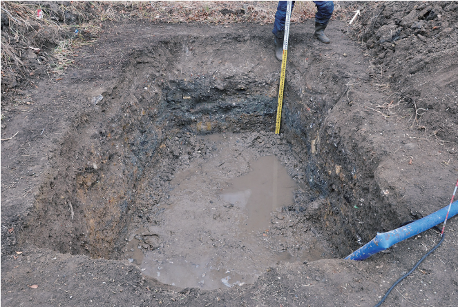
③ 1トレンチ 完掘状況（1）（北西から）
