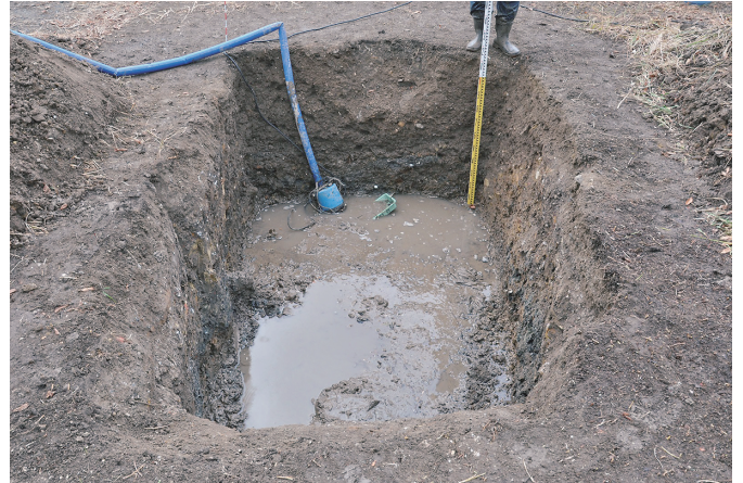
④ 1トレンチ 完掘状況（2）（南東から）
