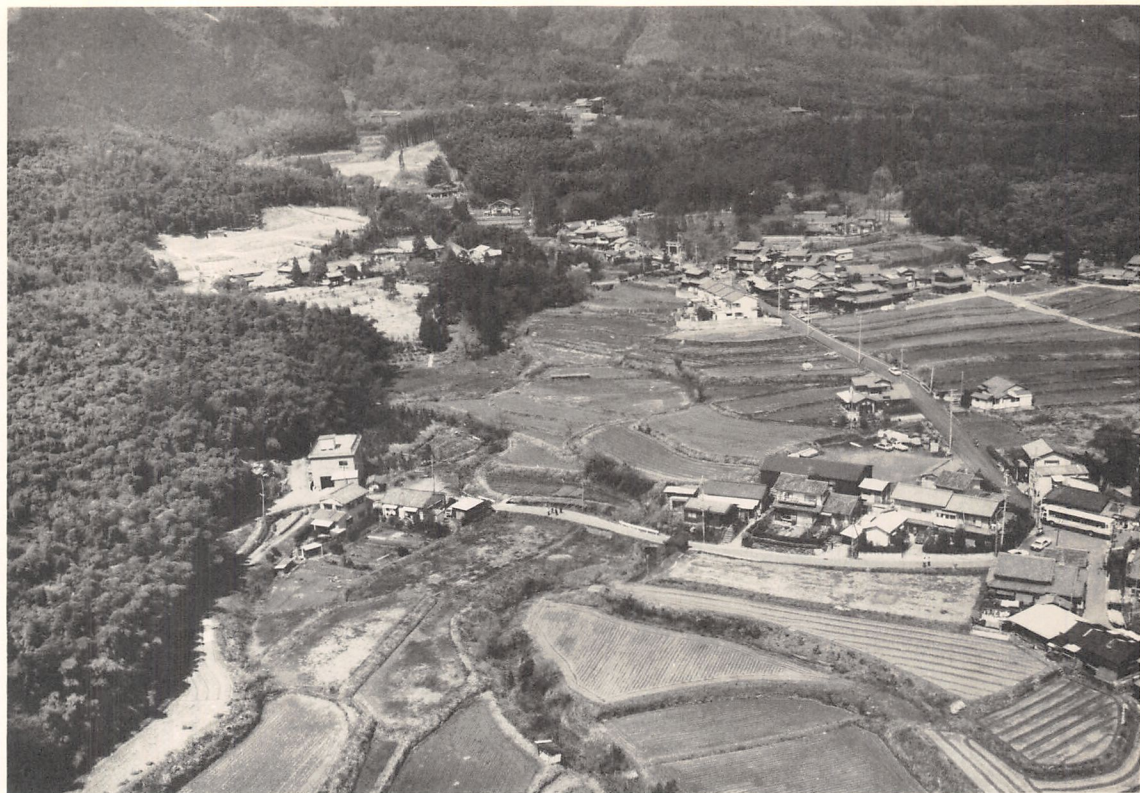
1 D地区全景（南東から）
