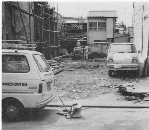
一般住宅立会調査
