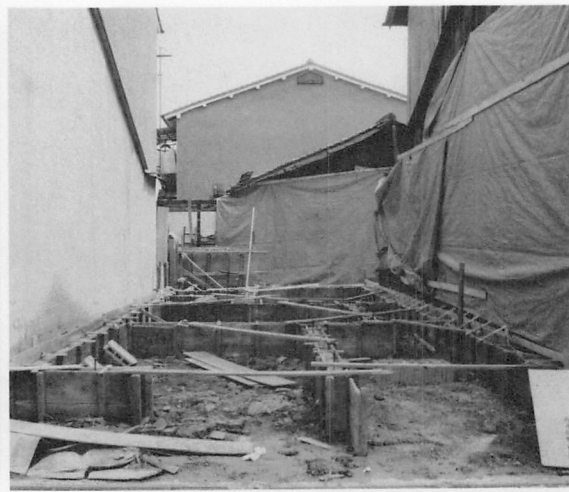
調査予定日以前に掘削終了
