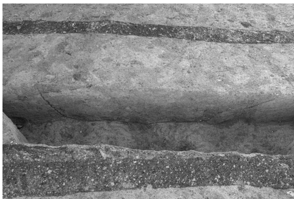
第19号土坑 断面（東から）
